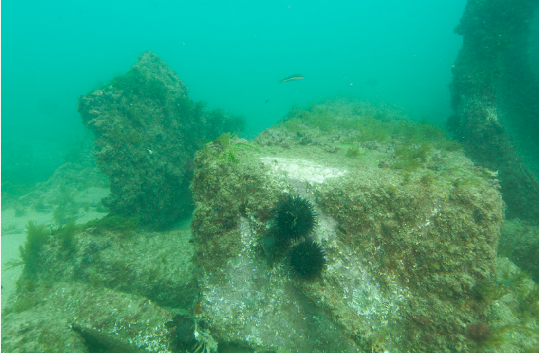
Las obras de desmantelamiento de los pantalanes de la antigua Central Térmica de Sant Adrià de Besòs, propiedad de Endesa, se vieron modificadas y se aconsejó el mantenimiento de las estructuras de hormigón más antiguas, ya que se habían dado una cierta recuperación del fondo marino y se encontraban colonizadas por una gran diversidad de especies. Se reorientó la actuación con vías a la creación de un futuro parque de arrecife artificiales marinos.
