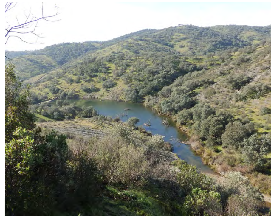
➤ Figura II. Presa principal construida en el arroyo Descuernavacas. Autor: José María Sierra.
