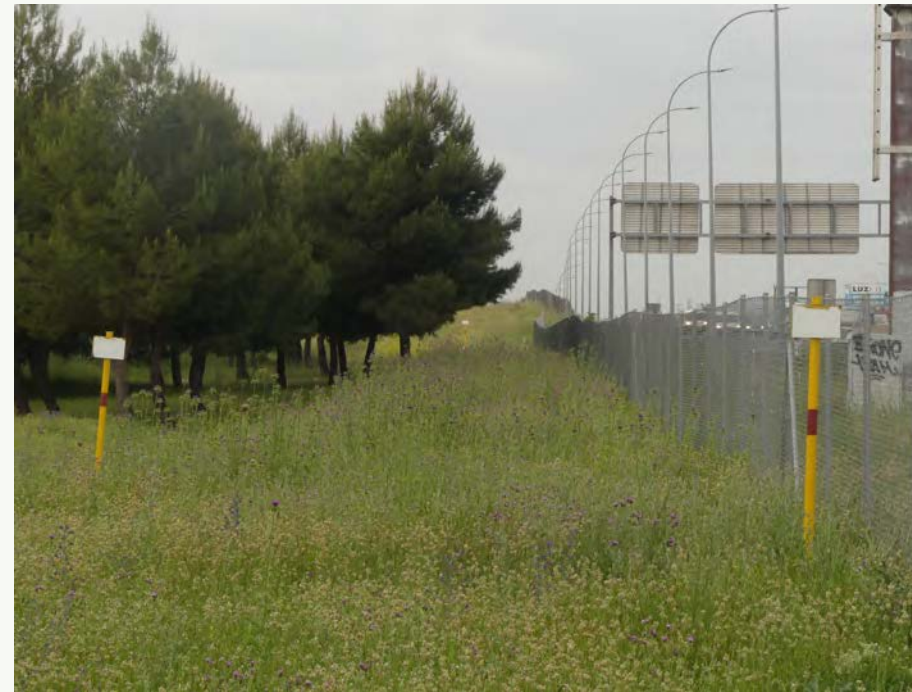
➤ Figura III. A la izquierda se aprecia cómo, a su paso por este encinar, la instalación del gasoducto ha eliminado el arbolado de la traza, en este caso encinas ( Quercus ilex subsp. ballota ). La señalética advierte de su presencia. Unos años después de su instalación la vegetación ha colonizado el trazado con un pastizal terofítico y arbustos dispersos de cantueso ( Lavandula stoechas subsp. pedunculata ) y retama ( Retama sphaerocarpa ), aunque en la zona de servidumbre permanente no se permitirá que se desarrollen encinas u otro arbolado que con su sistema radicular pueda comprometer la infraestructura. Sevilla la Nueva (Madrid). A la derecha un caso muy frecuente en el que el gasoducto discurre en paralelo a otra infraestructura previa, en este caso una autovía. De esta manera se evitan nuevas afecciones, pero por otro lado se amplifica el ancho de banda al sumarse ambas infraestructuras. Autovía A-42 a su paso por Villaverde (Madrid). Autor: Ignacio Mola
