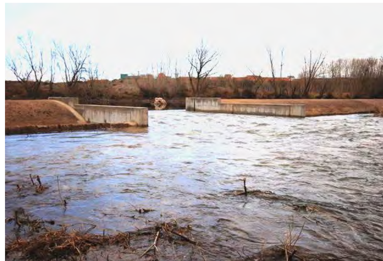
➤ Figura IV. Obra de conectividad longitudinal. Azud de Alcoba tras eliminar parte del mismo y sustituirlo por un azud de tipo móvil. Autoría: Confederación Hidrográfica del Duero.
