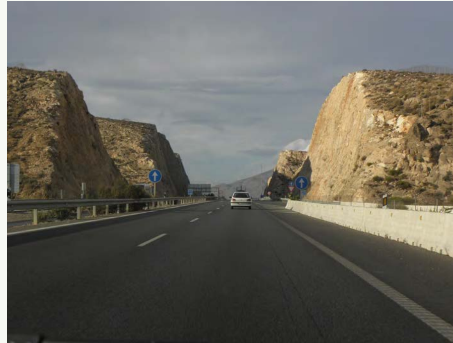
> Figura VII. A la izquierda una carretera comarcal en pleno corazón de la sierra de Gredos (Hoyos del Espino, Ávila), construida a principios del siglo XX. Se puede apreciar cómo se adapta al relieve mediante un trazado sinuoso. A la derecha una autovía del siglo XXI, donde la plataforma de la infraestructura se impone sobre esta sucesión de laderas (A-7, Almería). Autor: Ignacio Mola.
