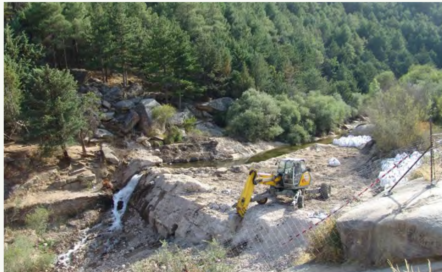
➤ Figura VIII. Demolición de azud en el río Manzanares (La Pedriza).
