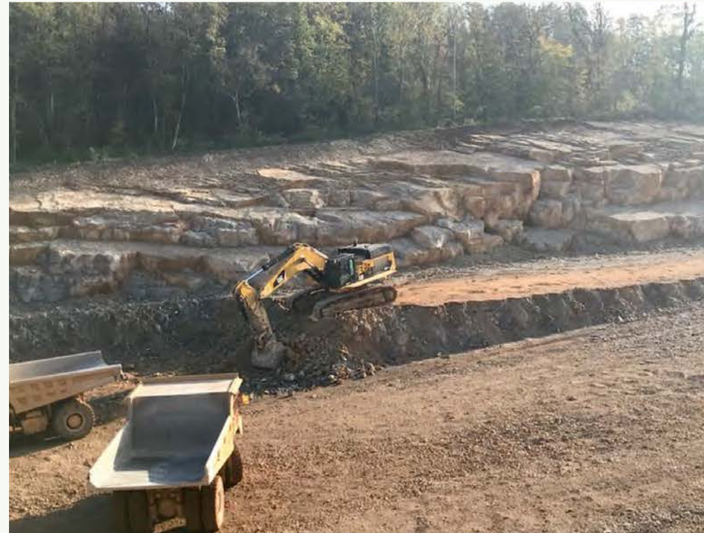
➤ Figura VIII. Ejemplo de RG siguiendo el método del Talud Royal. Izquierda, final de la fase operativa. Derecha, acabado final. Carretera RN 19, Departamento de Alto Saona (Haute-Saône) Francia. La estructura del nuevo talud rocoso se articula a partir de sus discontinuidades. Autor: P. Royal.
