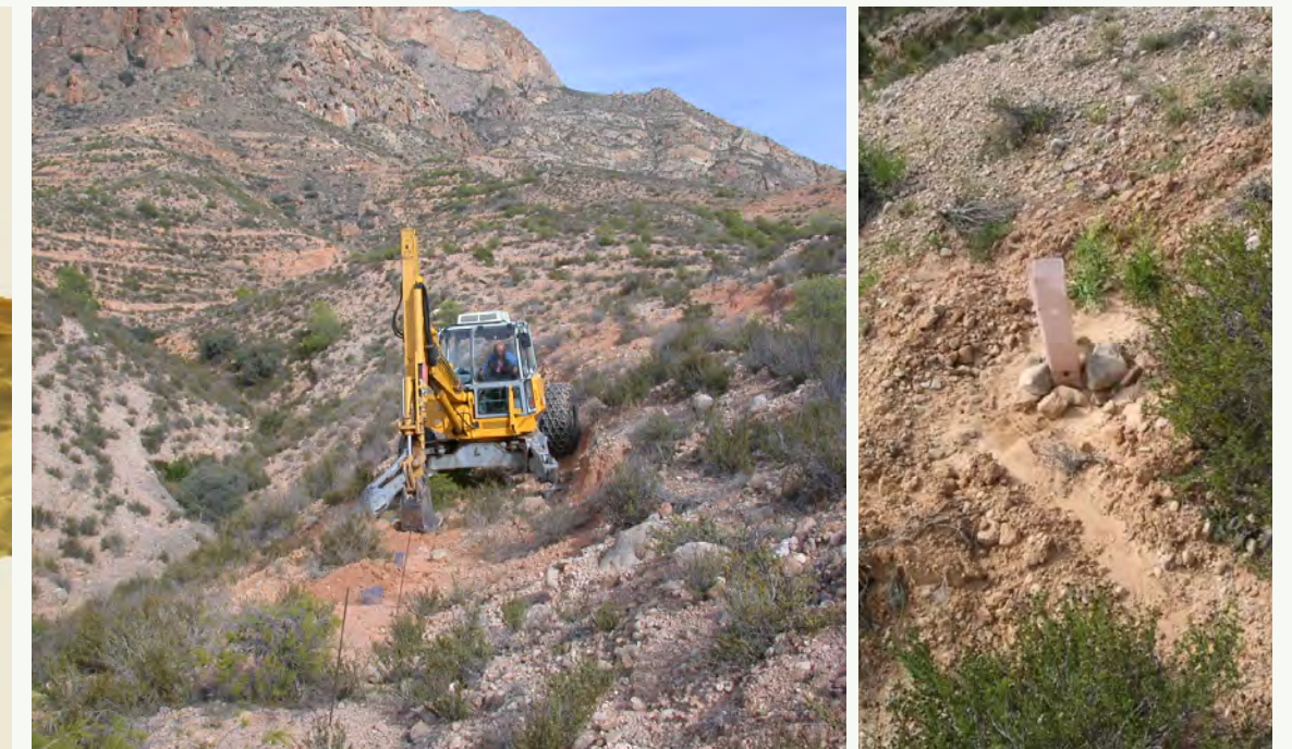
> Figura III. Vista desde la parte superior de la cuenca de la zona de actuación, donde se observa la retroaraña efectuando el ahoyado en la zona de las terrazas (izquierda) y detalle de un hoyo de plantación con microcuenca y tubo protector para la reducción de la radiación (derecha). Autor: A. Vilagrosa.
