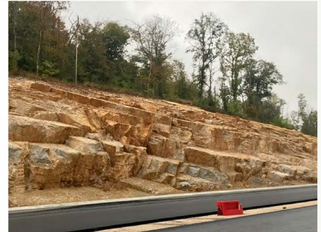
➤ Figura VIII. Ejemplo de RG siguiendo el método del Talud Royal. Izquierda, final de la fase operativa. Derecha, acabado final. Carretera RN 19, Departamento de Alto Saona (Haute-Saône) Francia. La estructura del nuevo talud rocoso se articula a partir de sus discontinuidades. Autor: P. Royal.
