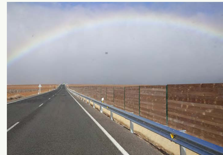
➤ Figura IV. Pantalla antisal y bionda instalada en el lavajo del Jaral (diciembre de 2017). Autor: Ramón García Pereira.
