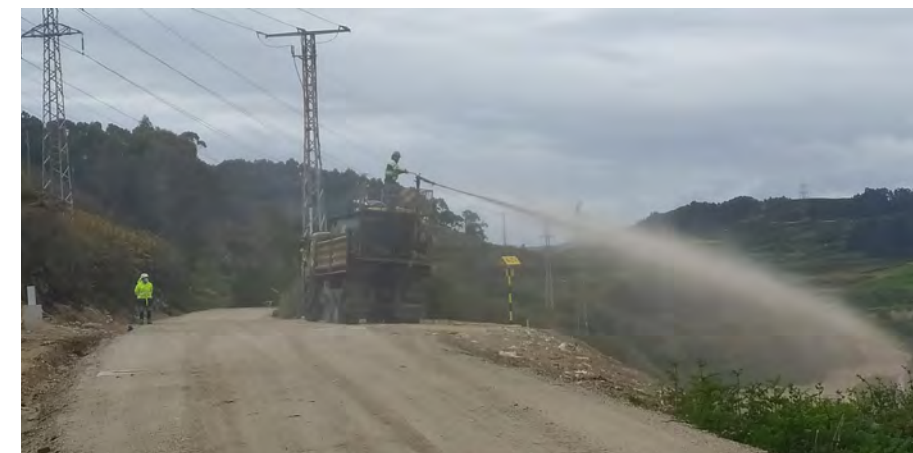
Figura I. Hidrosiembra de taludes. Autor: Ricardo Medín Souto.
