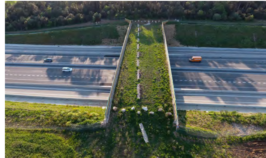
➤ Figura I. Vista general del paso superior específico para la fauna. Autores: Minuartia.
