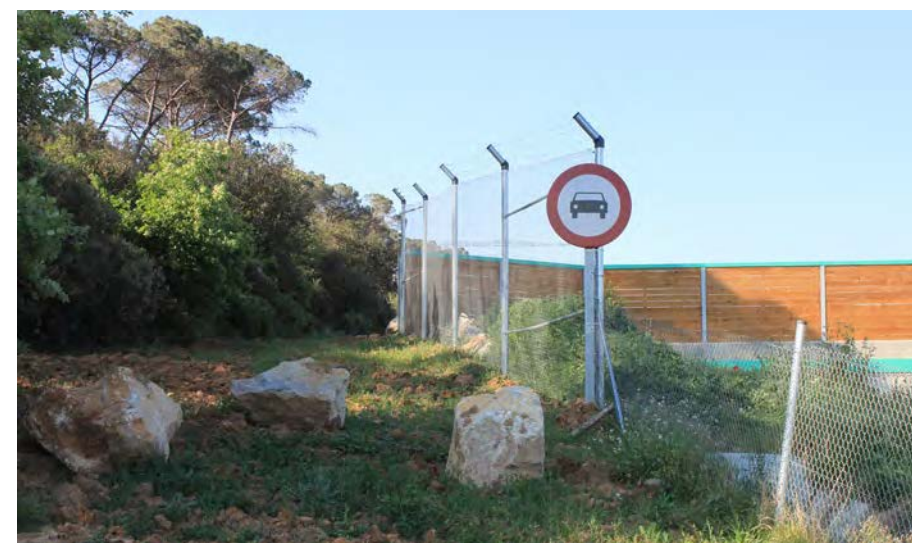
➤ Figura III. Vista desde la vía y detalle de la pantalla para reducir perturbaciones que cuenta con adaptaciones antivandalismo. Señalización y bloques de piedra para impedir el paso de vehículos. Autores: Minuartia.
