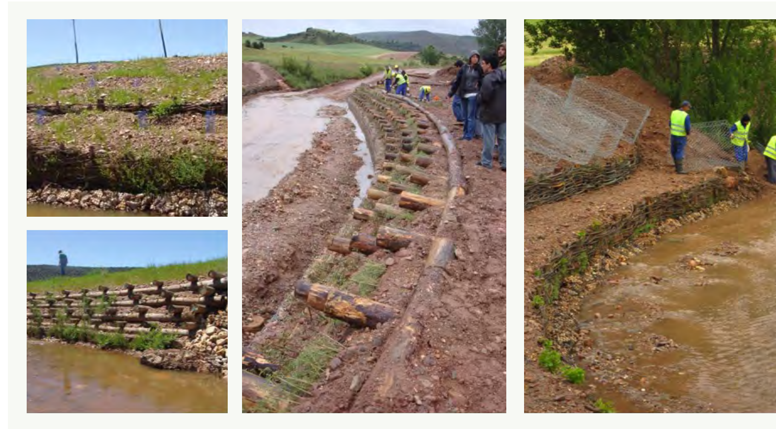
➤ Figura IX. Estructuras de bioingeniería (faginas y kramer) usadas para estabilizar orillas (Riba de Saelices, Guadalajara).
