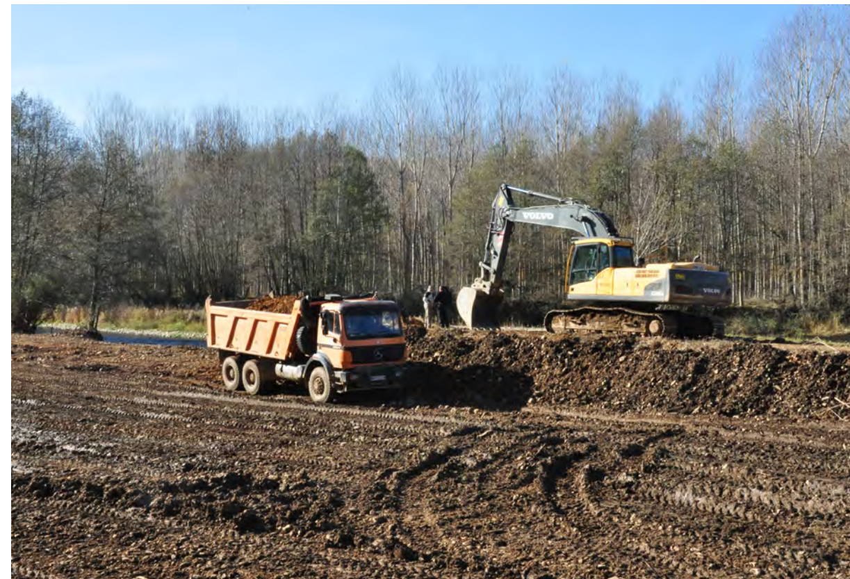
➤ Figura II. Caimanes del Tejar. Eliminación de mota en el margen izquierdo del río Órbigo. Autoría: Confederación Hidrográfica del Duero.
