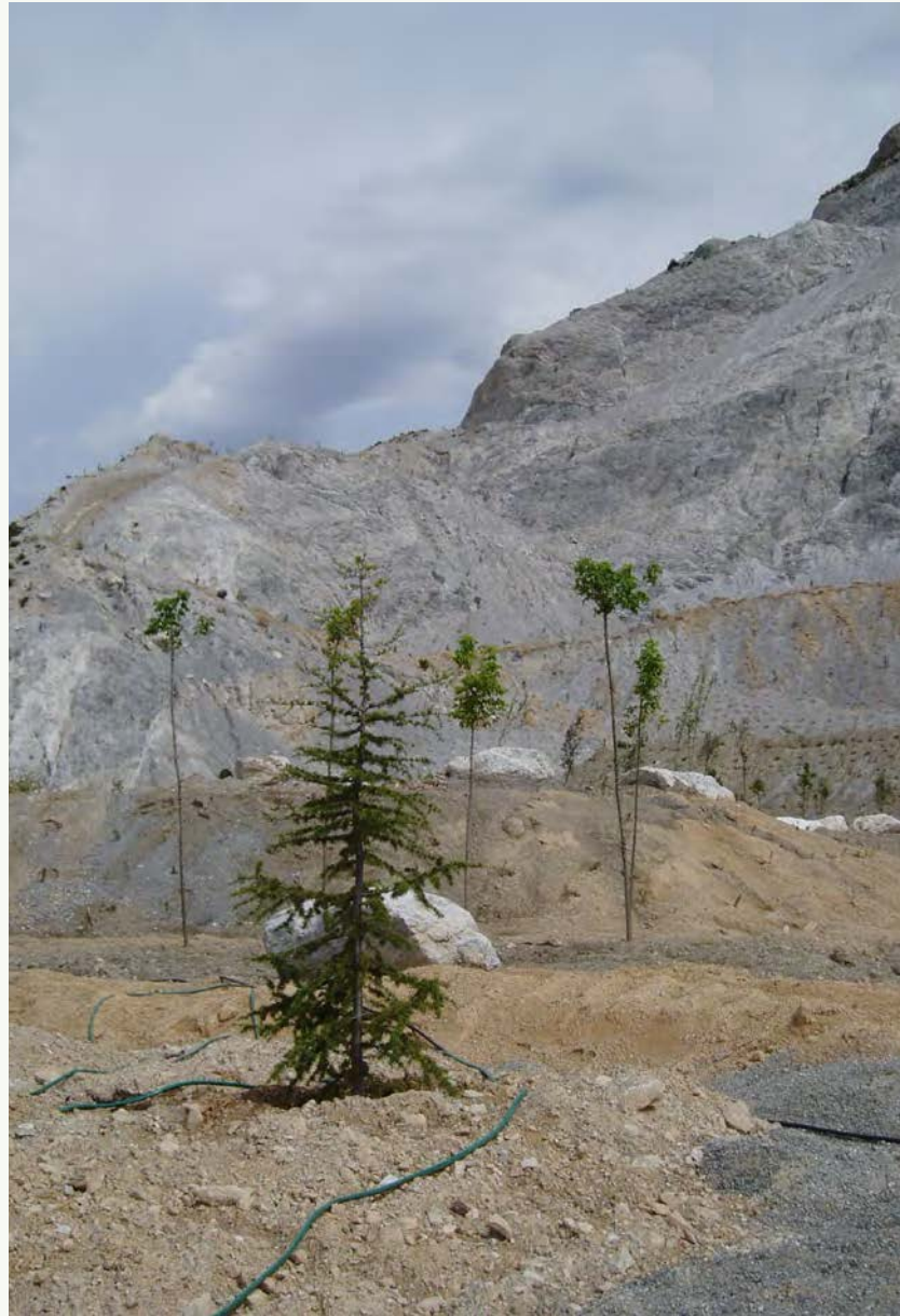
➤ Figura IX. Imagen de una restauración fallida en una cantera de dolomías (Padul, Granada, año 2009). No existe una remodelación del terreno ni estabilización de taludes, y, además, se utiliza sustrato inespecífico. La selección de especies, todas ellas especies de jardinería, alóctonas en su mayoría y con una nula adaptación a los sustratos de dolomías, fue totalmente inadecuada. En la actualidad ha desaparecido la práctica totalidad de los individuos plantados. Autor: Juan Lorite.
