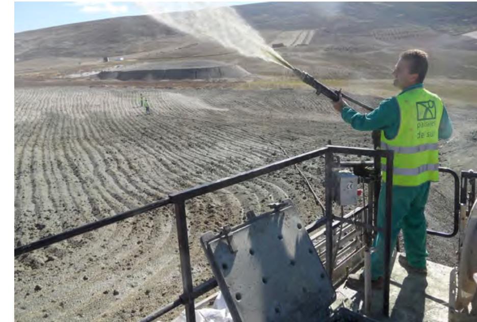
Figura 1. Hidrosiembra de la parcela de 2,6 ha con una mezcla de semillas de especies de yesos (gipsófitos y gipsovagos), en noviembre de 2011. Autor: Juan Lorite.
