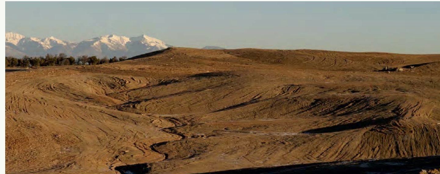
➤ Figura IV. Restauración mediante GeoFluv en la mina La Plata, Nuevo México (Estados Unidos), donde nació el método. Imagen superior, reconstrucción de una gran escombrera minera, con anterioridad al proceso de revegetación. Imagen inferior, otro sector de la escombrera tras dos años desde su semillado, mostrando ya una comunidad vegetal diversa. Ambas imágenes muestran paisajes organizados sobre la estructura que tienen las cuencas hidrográficas naturales, con cauces principales zigzagueantes y meandriformes, de los que parten una serie de lomas y vaguadas alternas, que configuran laderas festoneadas, de perfiles longitudinales convexo-cóncavos. Esa estructura es idéntica a la de la mayoría de los paisajes de la superficie terrestre (véase la similitud de estos paisajes construidos con los naturales de la figura III). Autor: E.E. Epp.
