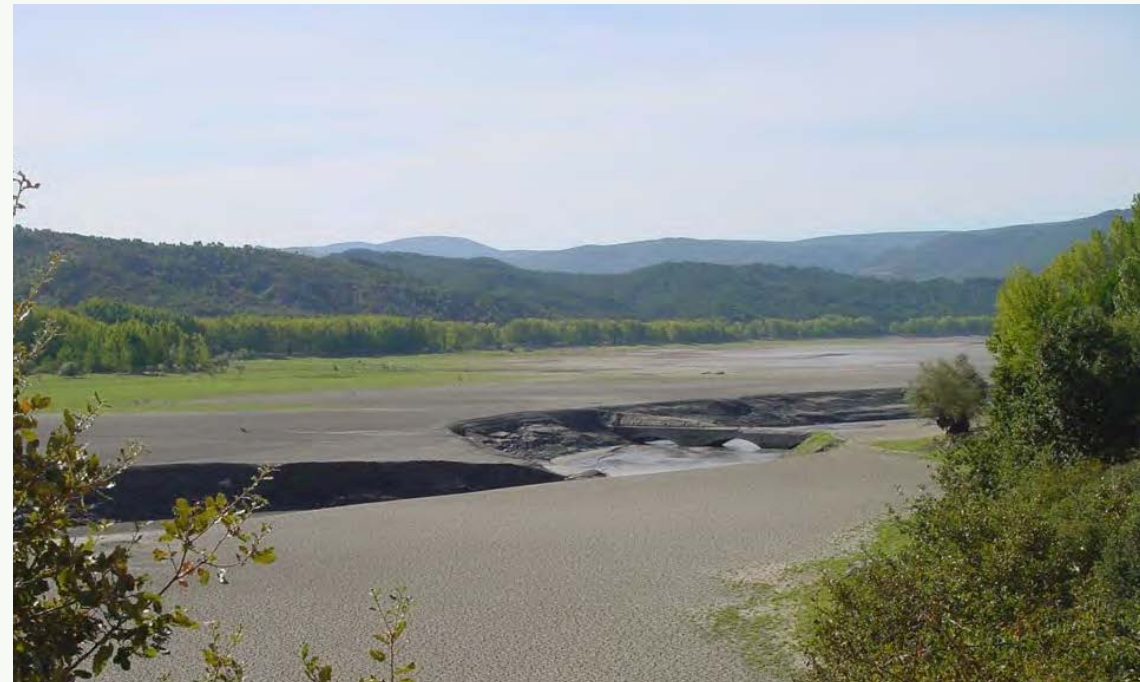
Figura III. Colmatación del embalse de Barasona por depósito de sedimentos.
