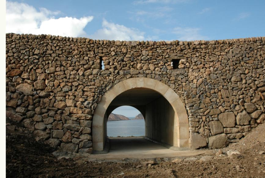
Construcción de un puente que permite mantener el camino existente sin interrumpir el curso natural de un torrente
