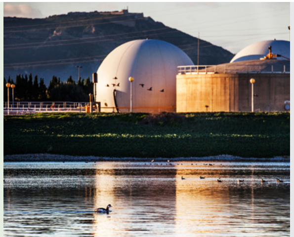
Balsa naturalizada de agua tratada en la depuradora Cabezo Beaza
