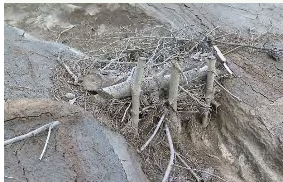
> Figura 1. Fase de construcción de las fajinas en la balsa minera. Detalle de una de las 26 albarradas encajadas en la red de drenaje de la balsa. Vista general de la balsa minera tras el fajinado (133 fajinas) y plantación de especies del hábitat 9570* (1.480 plantones). Autor: José Antonio Navarro Cano.
