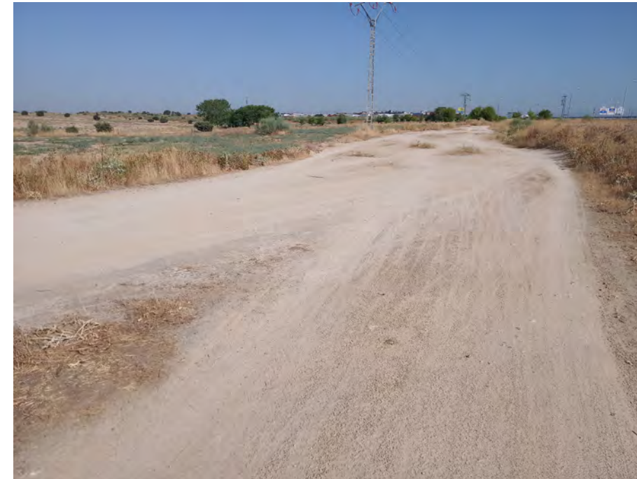
➤ Figura 1. Aspecto previo a las intervenciones de un tramo de vía pecuaria (Vereda de Castilla a su paso por Alcorcón) afectado por problemas de compactación, erosión y degradación de suelos. Autores: Francisco Martín Azcárate y Violeta Hevia Martín.
