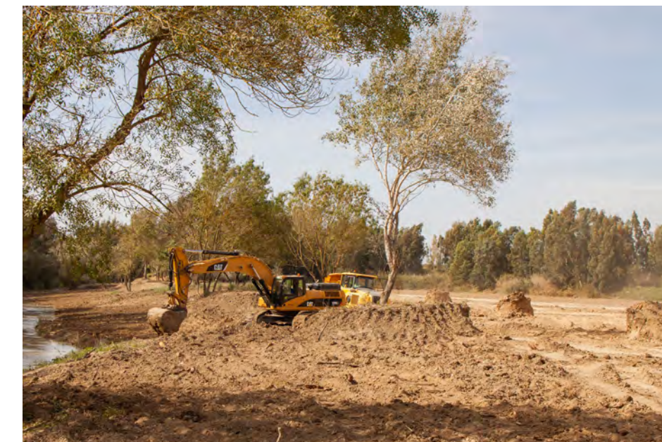
Figura III. Desarrollo de los trabajos. Eliminación de mota respetando vegetación autóctona. Autor: Luis Linares.
