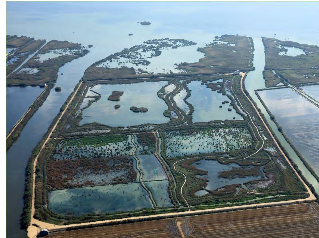
Figura 1. Vista aérea del Tancat de la Pipa. Autoría: Confederación Hidrográfica del Júcar.
