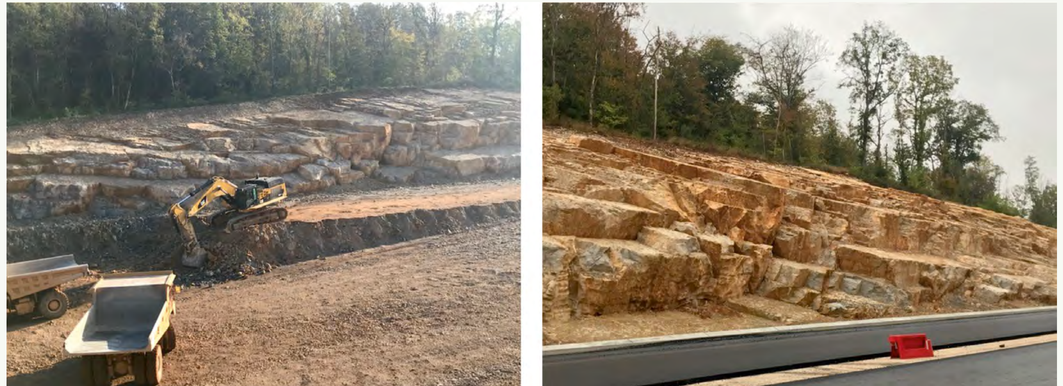
➤ Figura VIII. Ejemplo de RG siguiendo el método del Talud Royal. Izquierda, final de la fase operativa. Derecha, acabado final. Carretera RN 19, Departamento de Alto Saona (Haute-Saône) Francia. La estructura del nuevo talud rocoso se articula a partir de sus discontinuidades. Autor: P. Royal.
