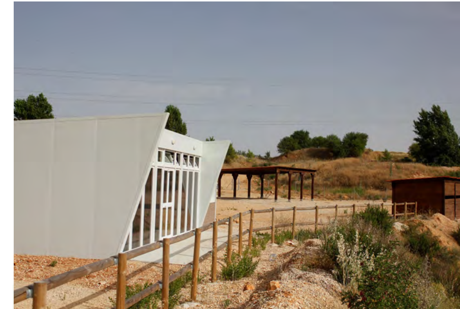
Figura III. Infraestructuras de uso público. Autora: Raquel Sánchez.
