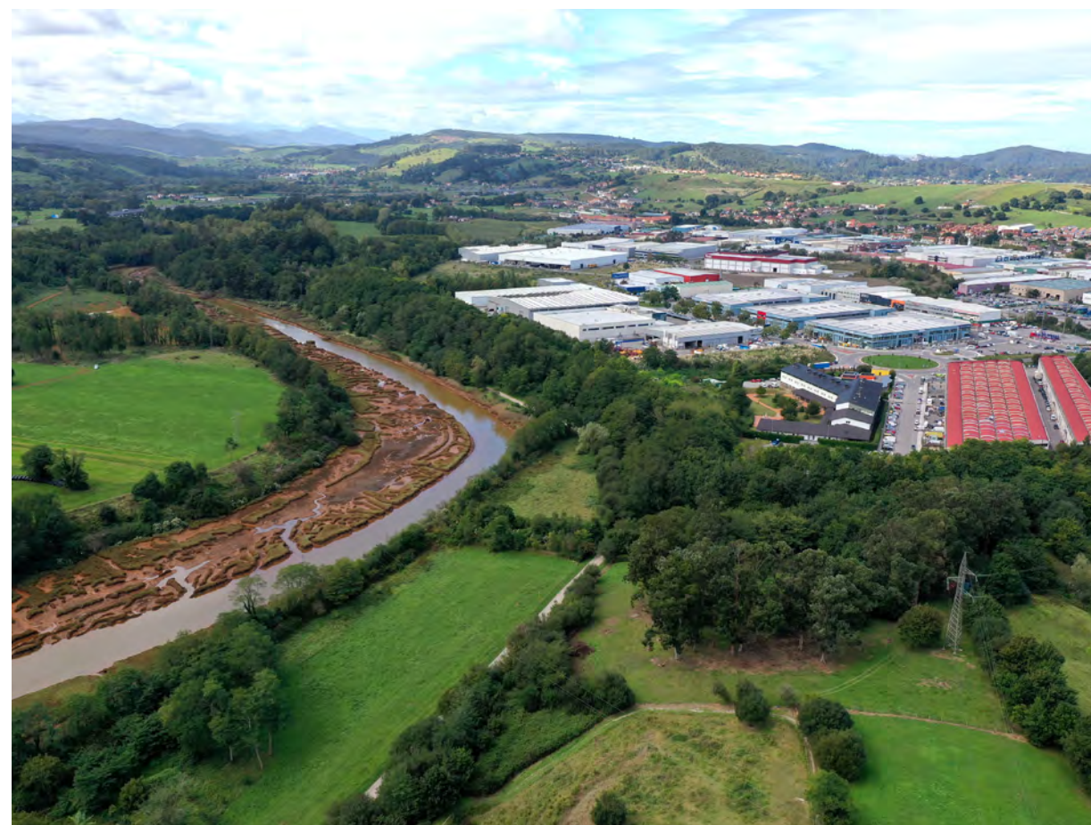
➤ Figura II. Para amortiguar el impacto de la construcción del polígono industrial de Morero, se restauró todo el talud de la antigua balsa que ocupa con la plantación de más de 40.000 árboles, que se ha transformado en la actualidad en un corredor verde junto a la ría de Solía. Autoría: SEO BirdLife.
