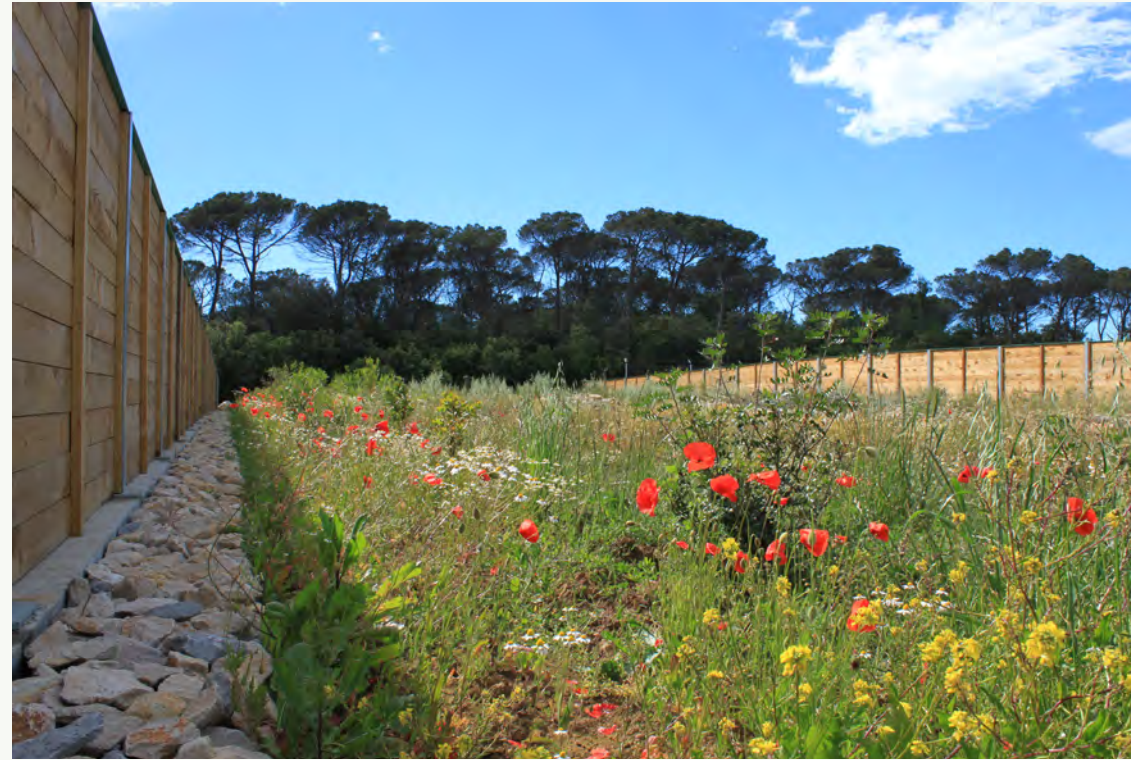
➤ Figura III. Paso superior de fauna construido sobre una autovía en funcionamiento (A2 en Fornells, Girona). Se trata de una actuación de permeabilización de la vía en la cual la restauración de la superficie del paso se realizó con particular atención para facilitar hábitats adecuados para invertebrados, entre ellos insectos polinizadores. Autoras: Carme Rosell, Joana Colomer.
