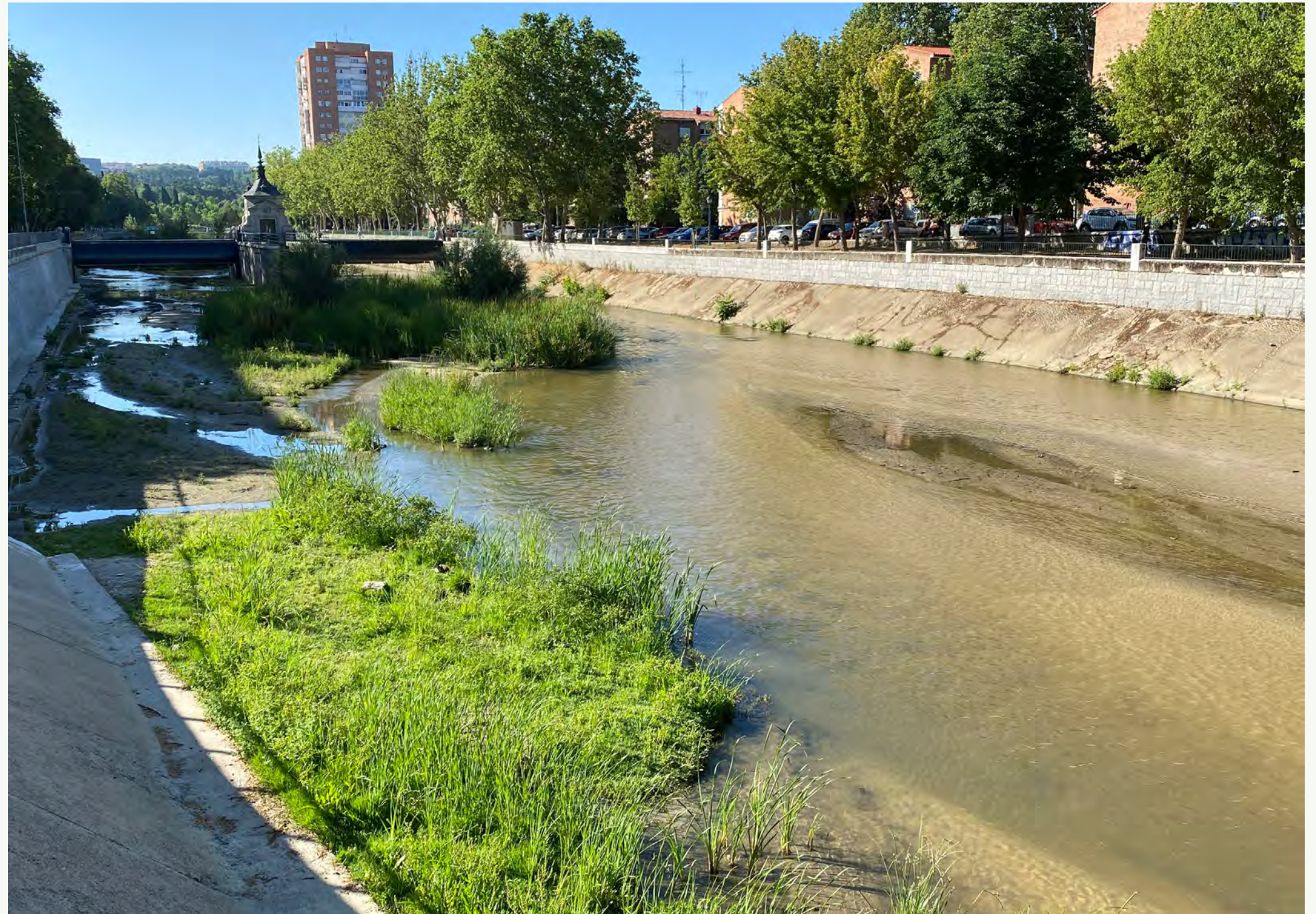
➤ Foto V. Tramo del río Manzanares a su paso por la ciudad de Madrid. La recuperación de la vegetación riparia y helofítica y de los bancos de arenas es debida a la apertura de las presas y el flujo longitudinal libre del agua; no obstante, el flujo transversal del agua está impedido por las grandes motas a ambos lados del río. Autor: © José María Rey Benayas.
