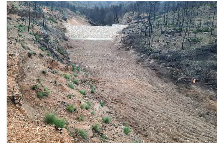
Figura 1. Dique de mampostería. Autor: Antonio Aroca García (Tragsa).
