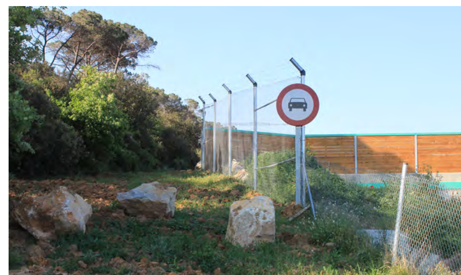
Figura III. Vista desde la vía y detalle de la pantalla para reducir perturbaciones que cuenta con adaptaciones antivandalismo. Señalización y bloques de piedra para impedir el paso de vehículos. Autores: Minuartia.
