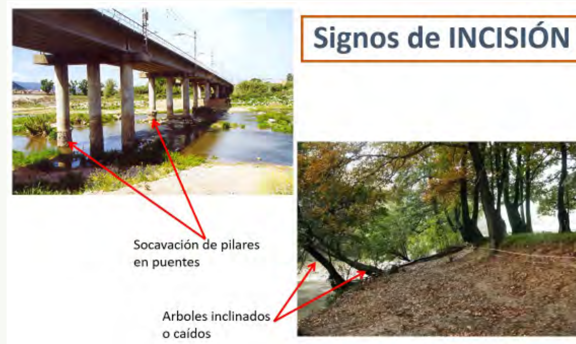
> Figura IV. Indicadores de incisión en el cauce. Los tramos fluviales aguas abajo de grandes presas con procesos de incisión son frecuentes debido al gran número de ellas.
