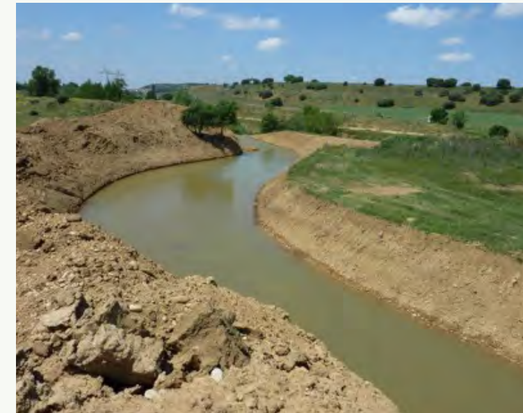
➤ Figura VII. Recuperación del cauce antiguo del río Sequillo en un tramo rectificado (Zamora).
