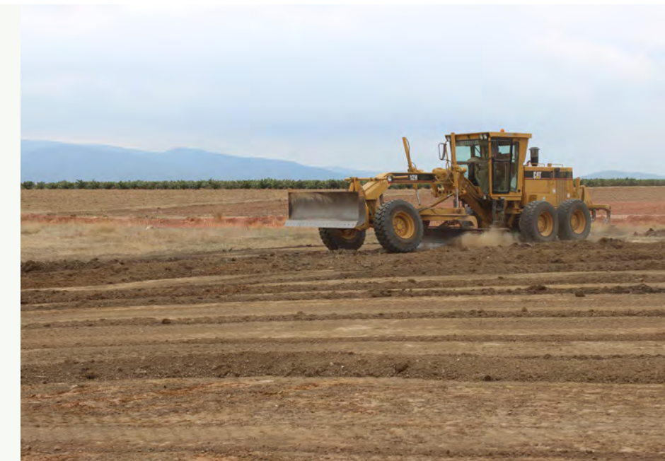
➤ Figura II. Reperfilado y nivelado del lavajo del Tío Bernardo. Autor: Ramón García Pereira.
