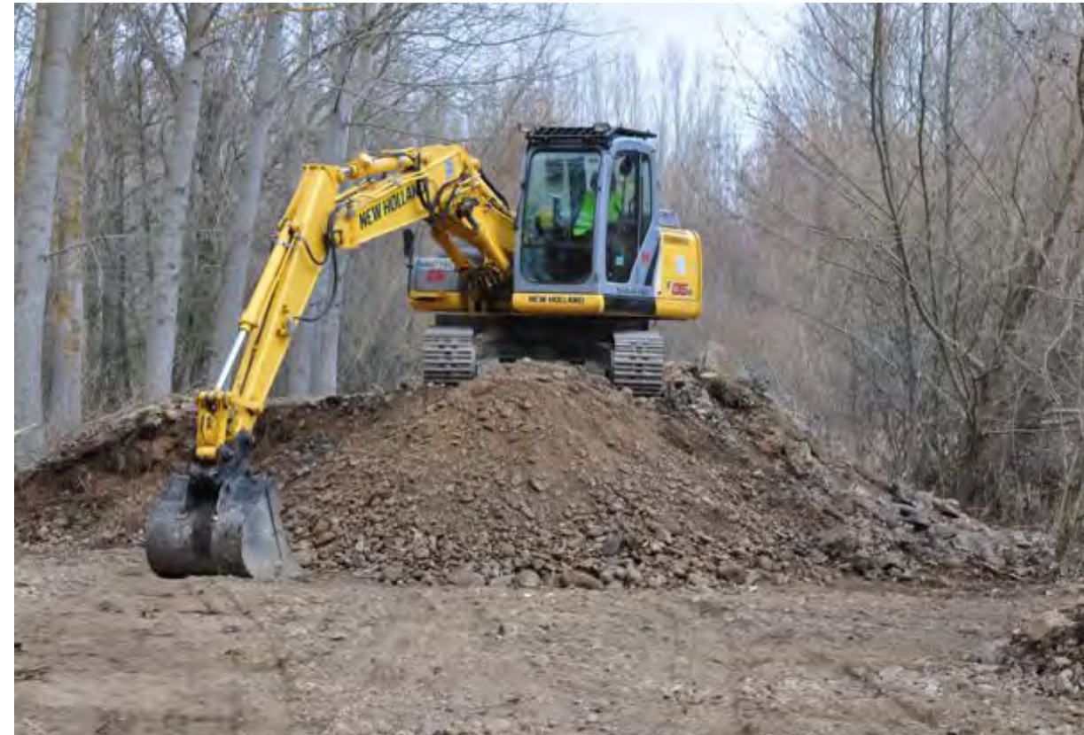
➤ Figura III. Detalle de eliminación de mota en el margen del río Órbigo, tramo I. Autoría: Confederación Hidrográfica del Duero.
