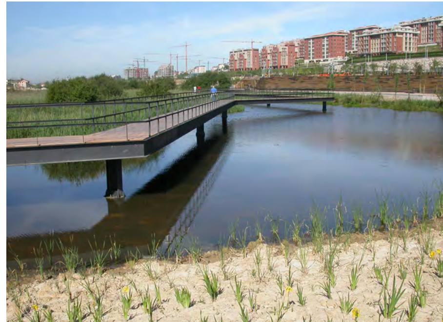
Figura I. Vaguada de Las Llamas, trabajos iniciales. Autor: Felipe González (SEO BirdLife).
