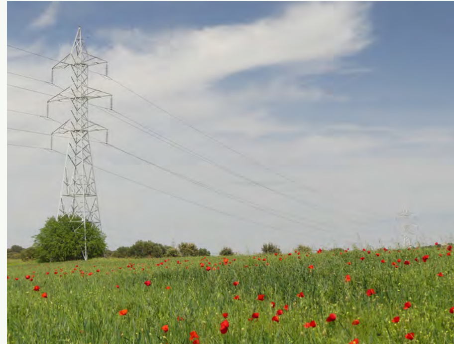
➤ Figura V. A la izquierda una línea eléctrica que discurre por una matriz agrícola con escasos puntos de vegetación natural de pequeño porte. Entorno de Yebra (Guadalajara). A la derecha, una línea eléctrica en una zona de bosque, en este caso de pinos piñoneros ( Pinus pinea ). La calle eléctrica se mantiene sin árboles para evitar cortes de suministro o riesgo de incendio. Pelayos de la Presa (Madrid). Autor: Ignacio Mola.
