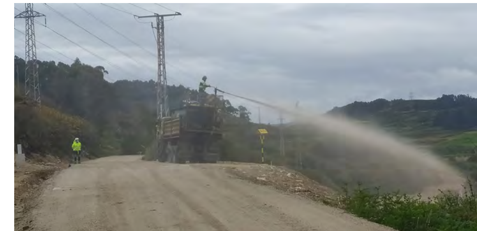
Figura I. Hidrosiembra de taludes. Autor: Ricardo Medín Souto.
