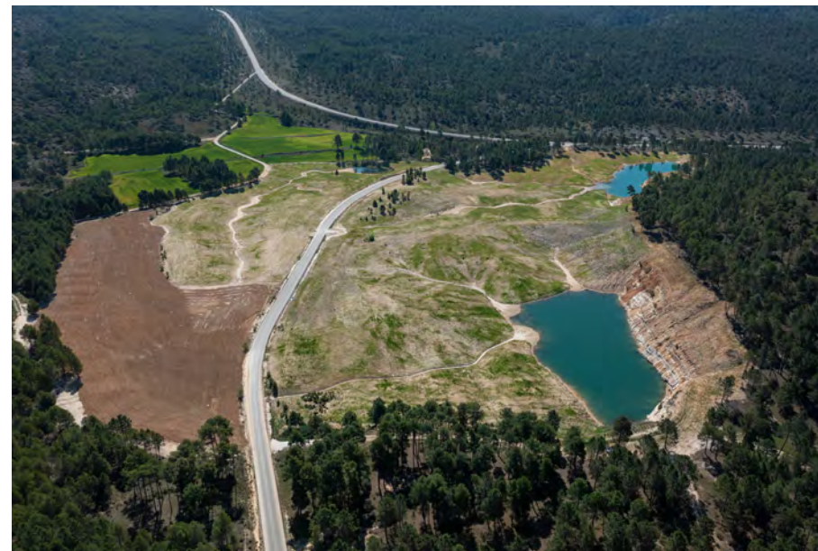
➤ Figura III. Vista aérea de la restauración ejecutada. Realizada en mayo de 2022. Autoría: SICA S. L.-Euroarce-Grupo SAMCA.
