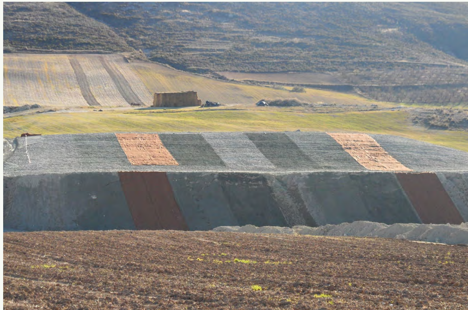
➤ Figura VIII. Parcelas experimentales de restauración de yesos en pendiente. Se ensayó con distintas técnicas de control de erosión. En las parcelas marrón claro se colocó una manta orgánica y en las parcelas gris oscuro se aplicó hidrosiembra (véanse los detalles en la ficha de restauración de yesos. Esquina inferior derecha del croquis de la zona experimental). Autor: Juan Lorite.
